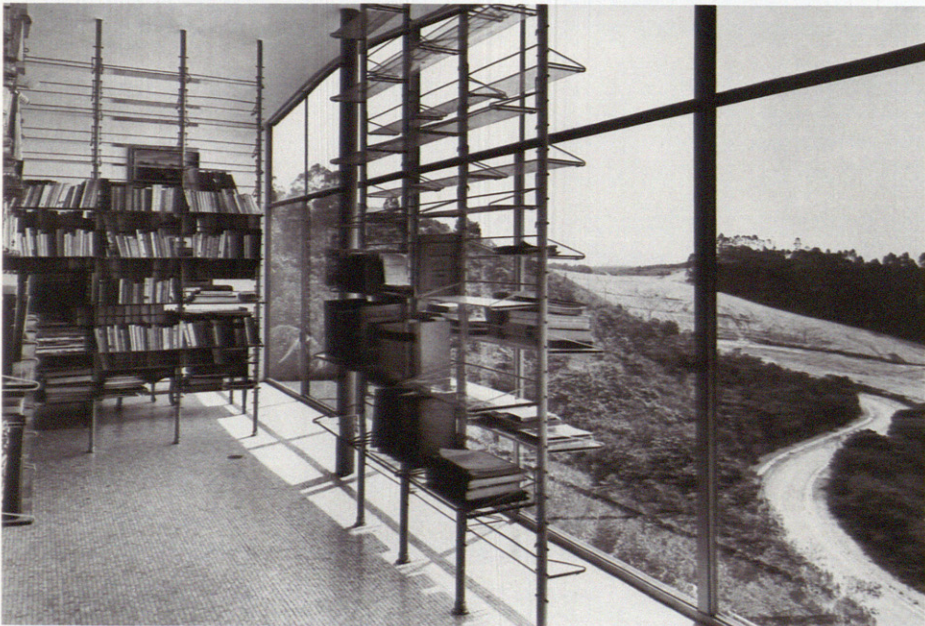
La ligereza de los pilares y las carpinterías dibuja los límites de la casa. The lightness of the pillars and the metalworks draw the house limits.
